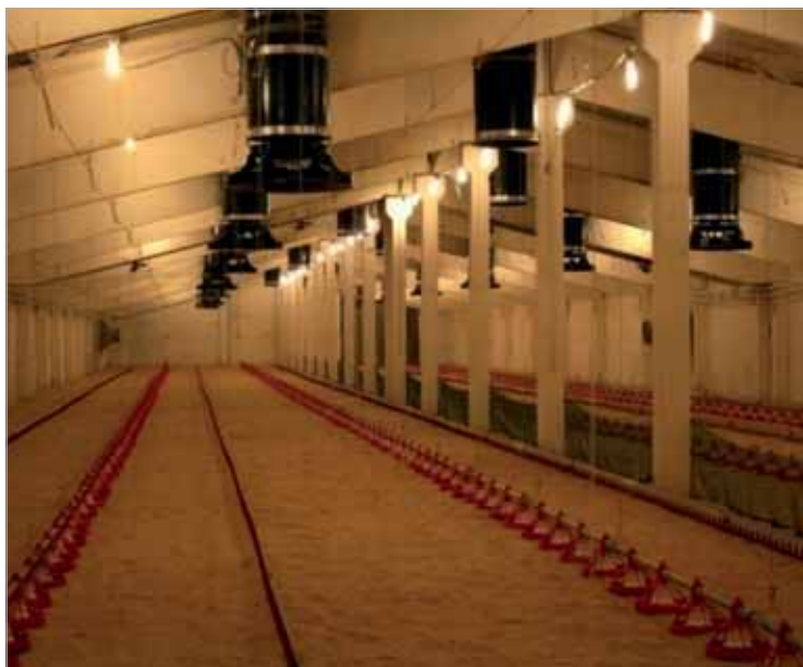
Один из залов ООО «Балтптицепром» после реконструкции
